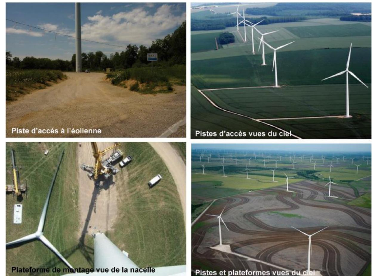
Figure 5 : Exemples de plateformes de montage et de pistes
